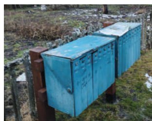
Adreses, kurās konstatētas bloku pastkastītes tiks demontētas
